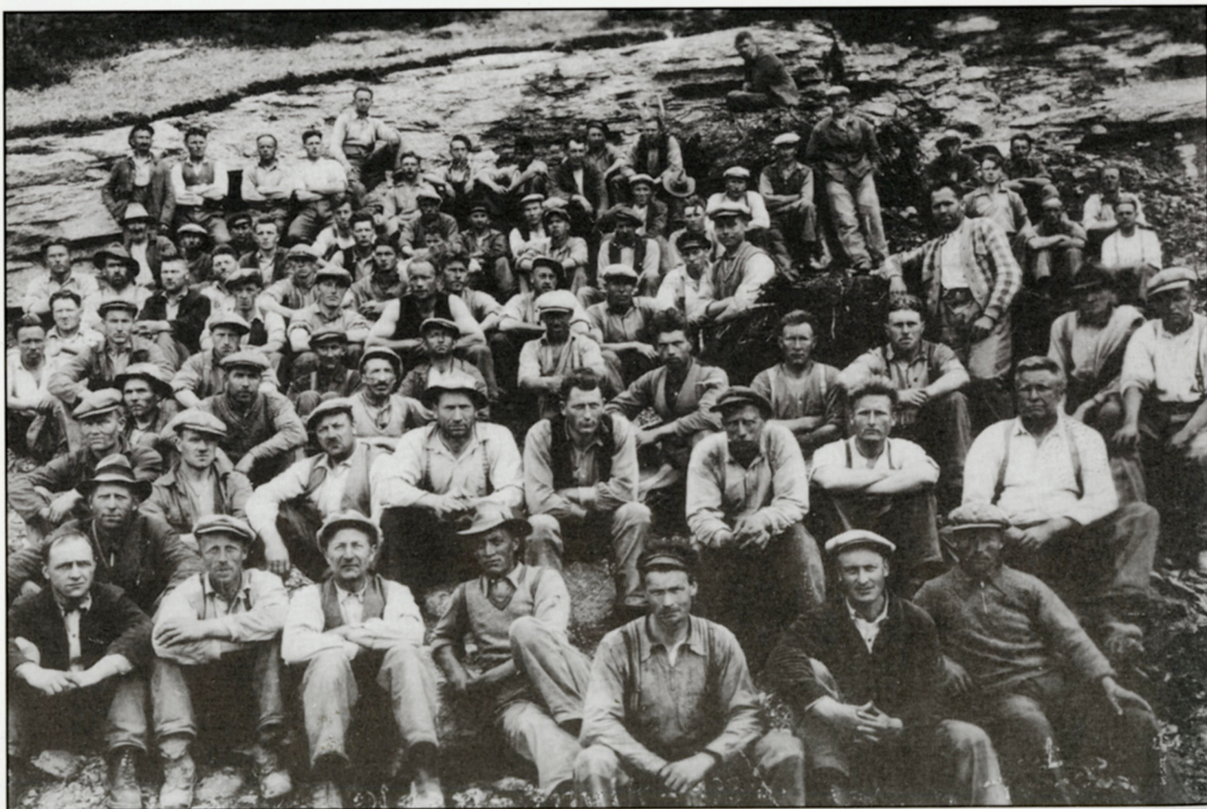
Ein traust arbeidsgjeng på veganlégget Olden-Innvik i 1936. Foto: Statens Vegvesen Sogn og Fjordane, arkiv.
